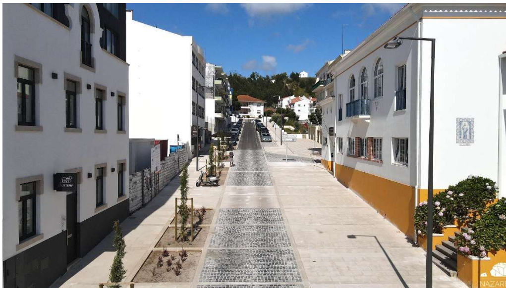
Figura 7 – Conclusão da 1.ª Fase da obra de requalificação da Avenida Guimarães.
