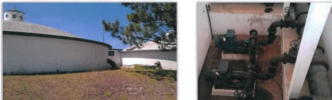
Figura 4.5. Reservatório e estação elevatória de Paliteira
