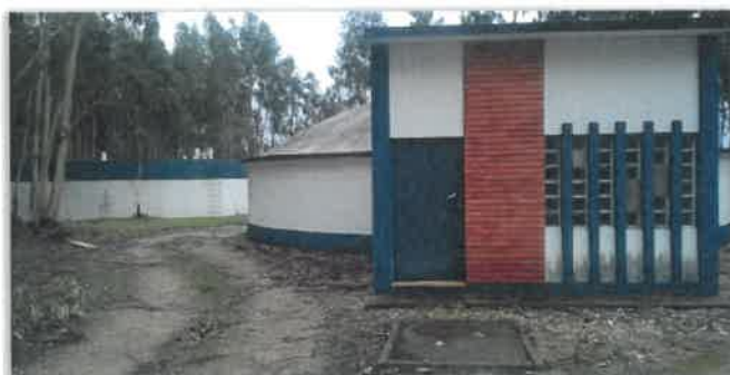
Figura 4.4. Reservatório de Valado dos Frades
