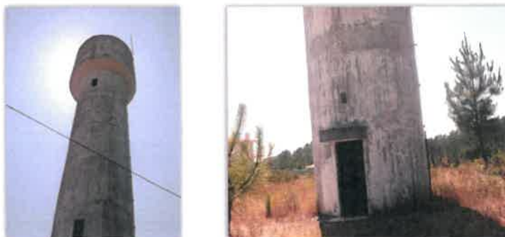
Figura 4.12. Reservatório de Fanhais
