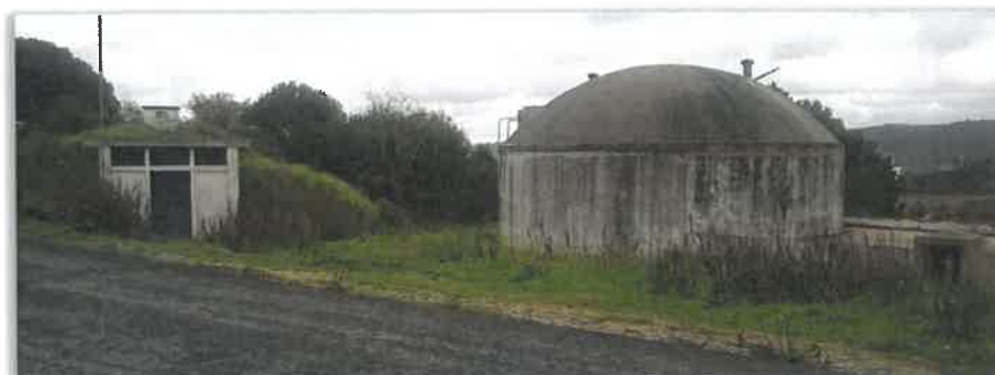
Figura 4.8. Reservatório de Famalicão
