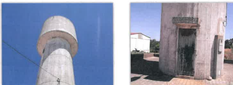
Figura 4.13. Reservatório de Raposos
