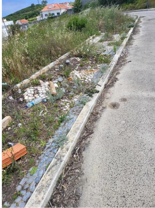
Foto 2 - Assentamentos de calçada e ausência pontual de pavimento nos passeios
