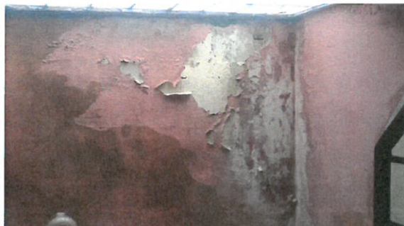
Foto n.º 2 – Vista da caixa de escadas
