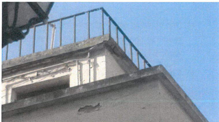
Foto n.º 5 – Vista exterior da laje de cobertura do prédio
