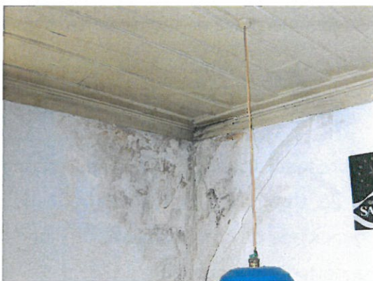
Foto n.º 3 – Interior da edificação
