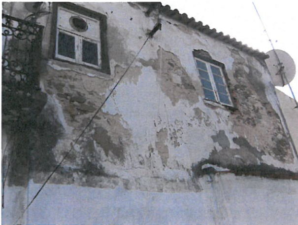
Foto n.º 1 – Fachada Norte
