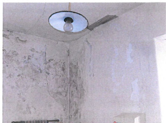
Foto n.º 4 – Interior da edificação
