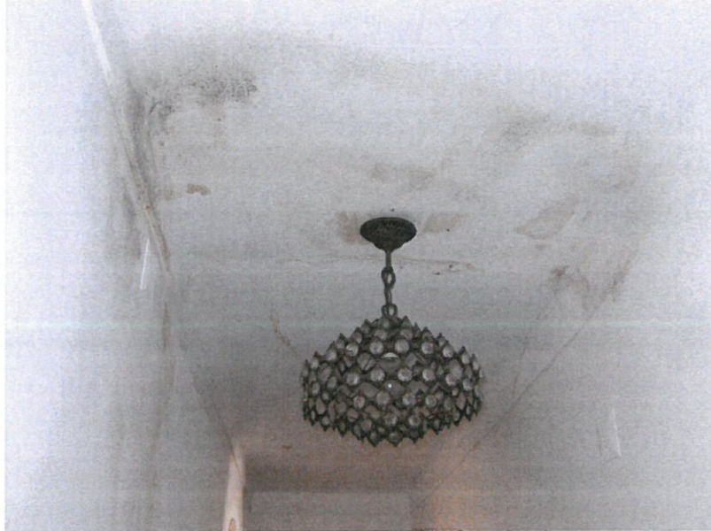
Foto n.º 1 – Teto do corredor da fração B
