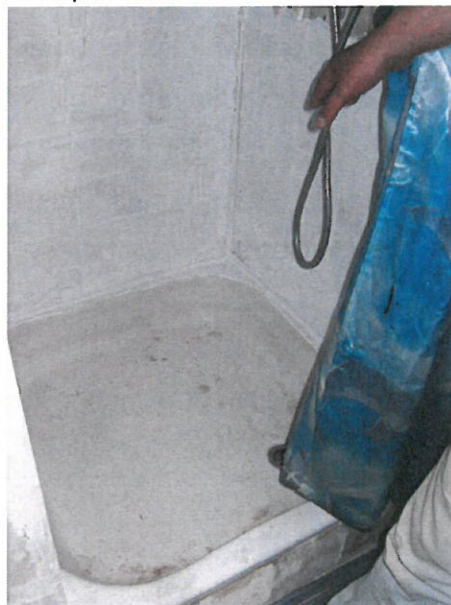
Foto n.º 2 – Equipamento sanitário, base de duche da instalação sanitária da fração C
