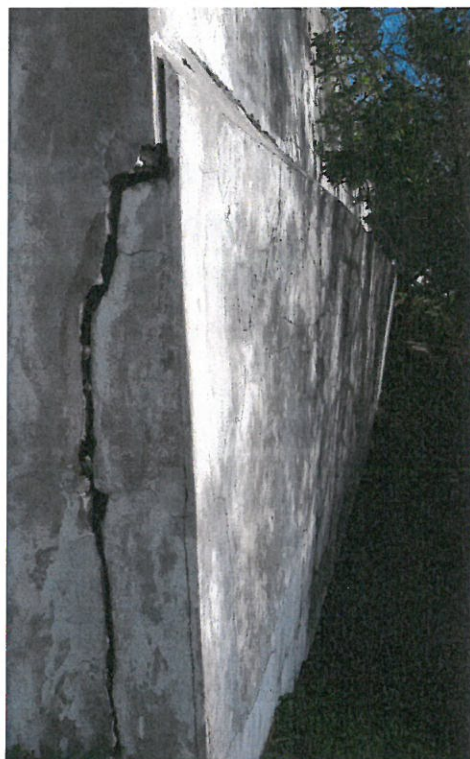
Foto n.º 1 – Vista parcial do muro de suporte do reclamante
