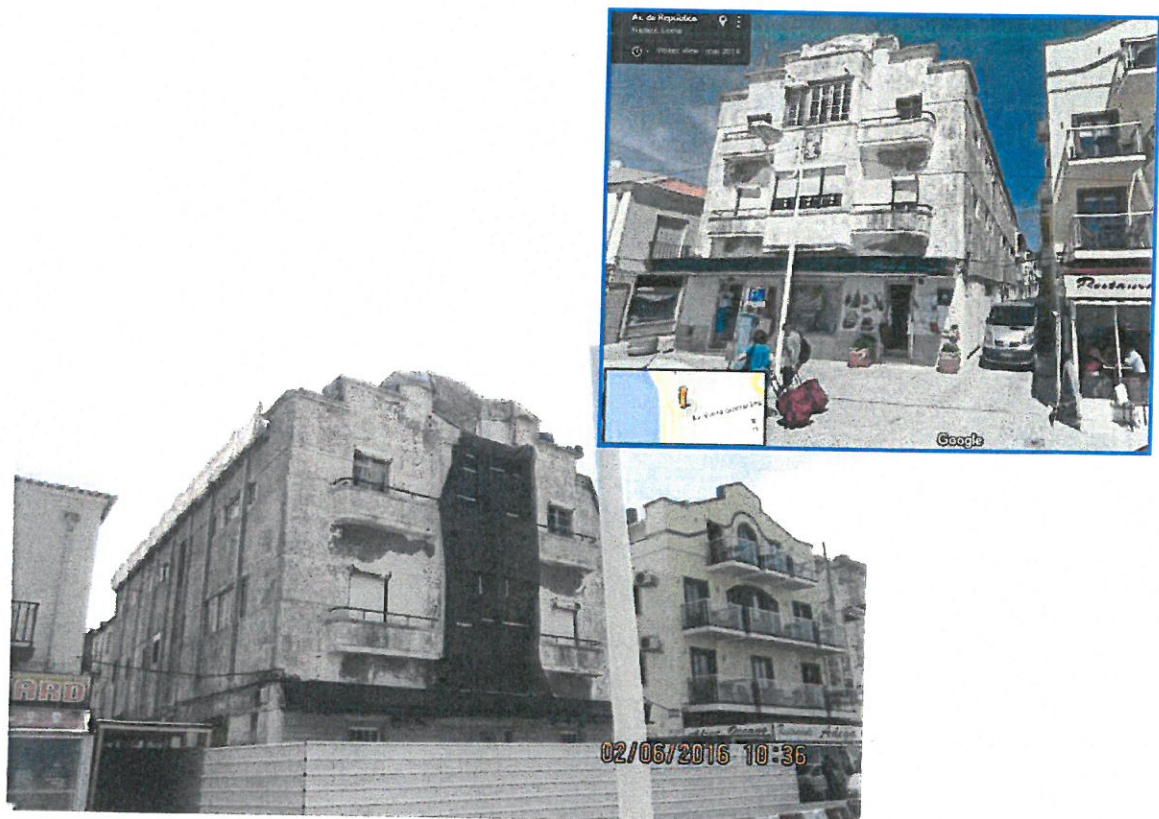
Figura 1.1 – Vista do edifício em maio de 2014 (Google Maps) e em 2 de junho de 2016, já com o perímetro de segurança montado após a ocorrência do acidente
