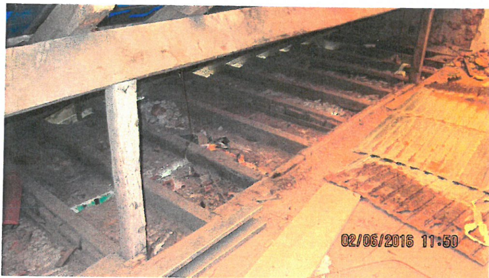
Figura 3.2 – Perfis metálicos colocados sobre a cobertura de madeira. Vigas do pavimento do sótão que rematam nas pernas das asnas
