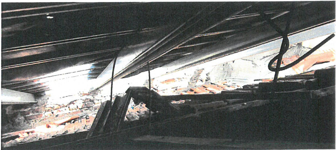
Figura 3.4 – Perfis metálicos apoiados no topo da platibanda norte. Não foram ainda retiradas as telhas da antiga cobertura
