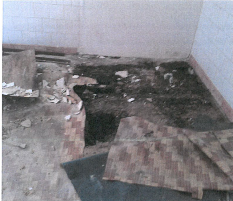
Foto n.º 3 – Pavimento da cozinha
