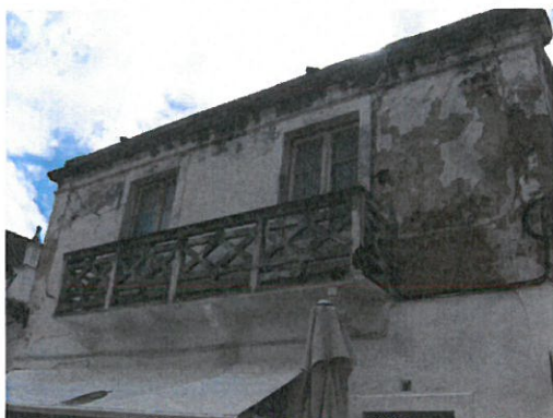
Foto n.º 5 – Fachada norte
