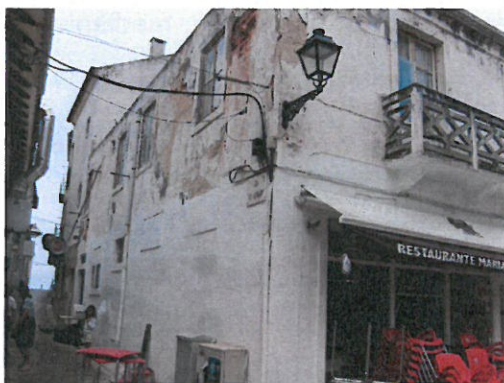
Foto n.º 1 – Fachada sul/ nascente
