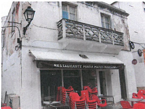
Foto n.º 3 – Fachada nascente
