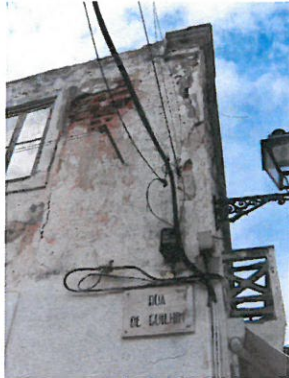
Foto n.º 7 – Fachada sul
