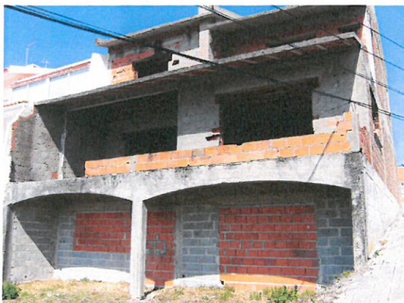
Foto n.º 1 – Vista exterior da moradia (Sudoeste).
