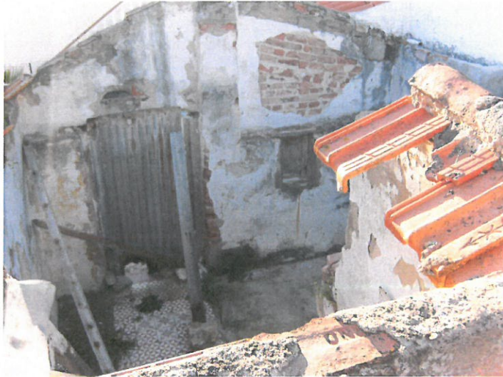
Foto n.º 1 – Vista geral da edificação
