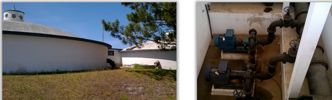
Figura 4.5. Reservatório e estação elevatória de Paliteira
