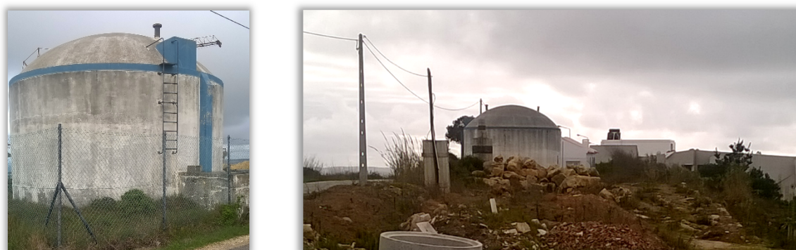
Figura 4.9. Reservatório 1 de Serra da Pescaria
