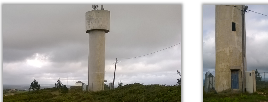
Figura 4.10. Reservatório 2 de Serra da Pescaria
