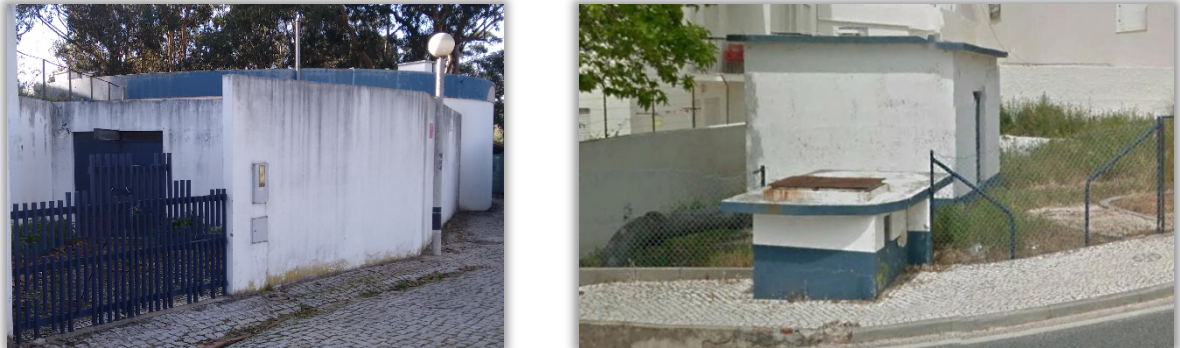
Figura 4.7. Reservatório da Sra. dos Anjos (dir.) e do Areal (esq.)
