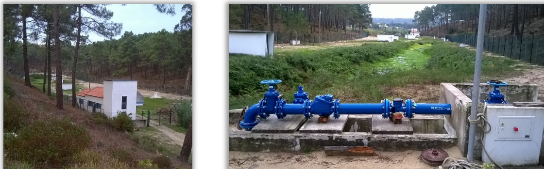
Figura 4.1. Parque de captações subterrâneas de Águas Belas
