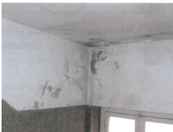
Foto n.º2 - Interior da caixa de escadas comum ao prédio
