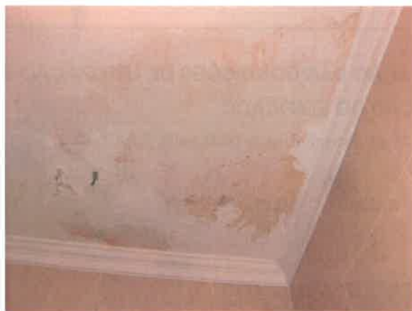
Foto n.º1 – teto da instalação sanitária
