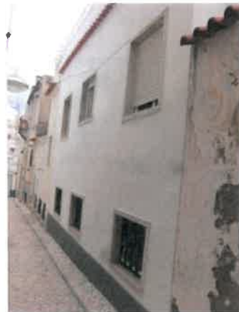
Foto n.º 7 – fachada norte
