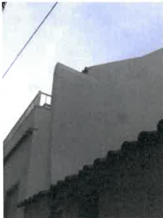
Foto n.º 6 – fachada norte
