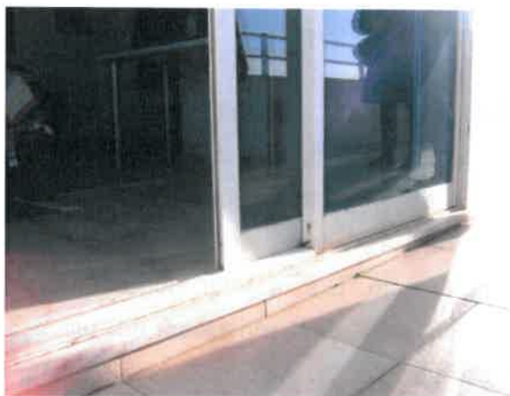
Foto n.º 3 – Pavimento da fração 15 andar
