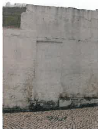
Foto n.º 3 - Vão de porta encerrado
