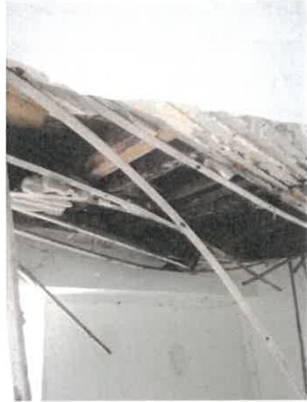
Foto n.º 2 – Teto interior de madeira
