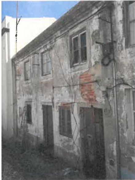
Foto n.º 1 – Fachada Principal
