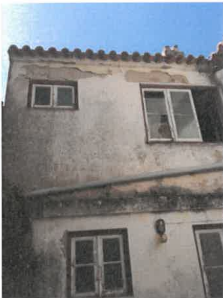
Foto n.º 3 – Fachada Posterior
