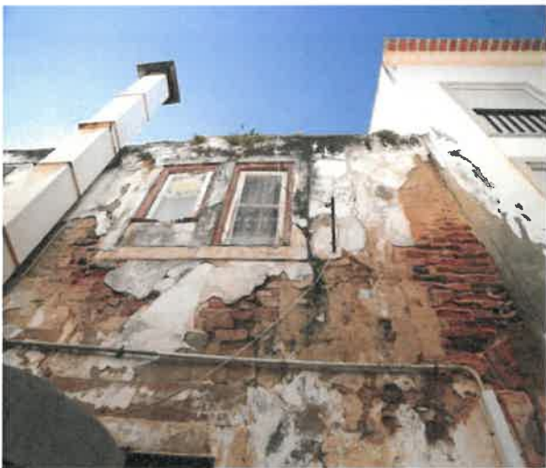
Foto n.º 5 – Fachada norte
