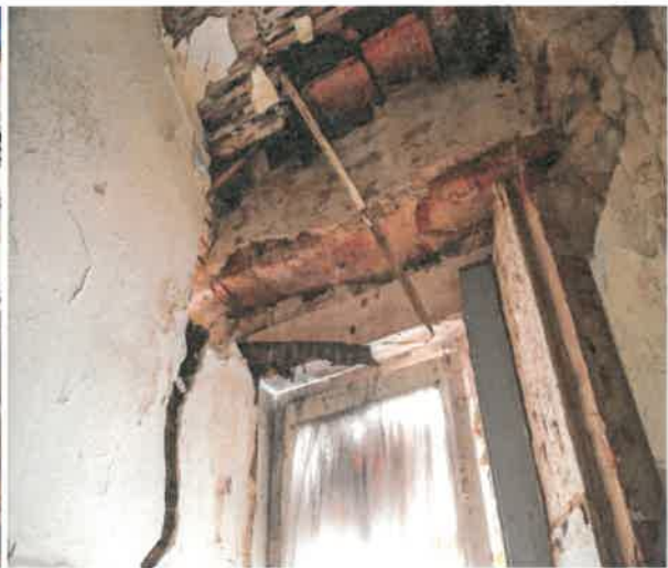
Foto n.º 6 – interior de compartimento do 1º andar
