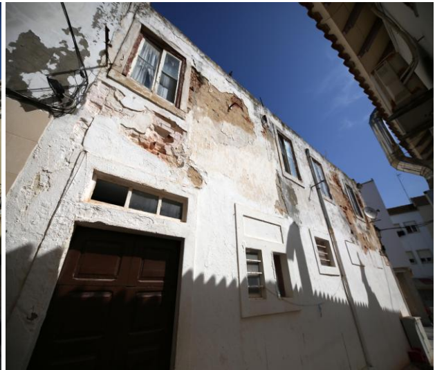
Foto n.º 2 – Fachada norte
