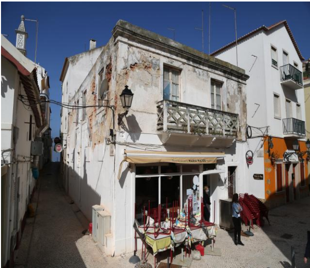
Foto n.º 1 – Fachada sul / nascente
