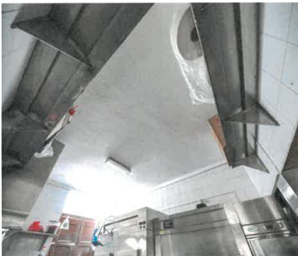
Foto n.º 3 – Interior do restaurante - cozinha
