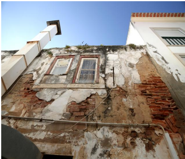
Foto n.º 5 – Fachada norte
