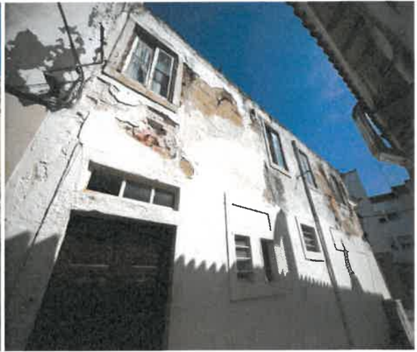
Foto n.º 2 – Fachada norte
