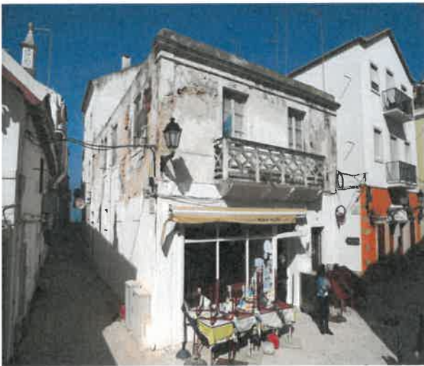
Foto n.º 1 – Fachada sul / nascente
