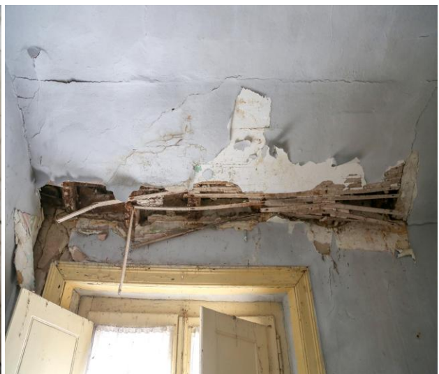
Foto n.º 8 – interior de compartimento do 1º andar
