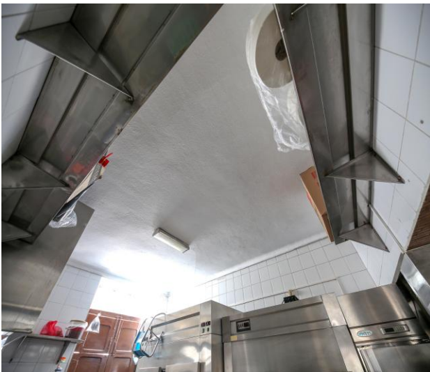
Foto n.º 3 – Interior do restaurante - cozinha
