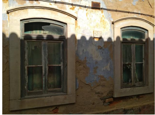
Foto n.º 6 – Vista das caixilharias e vidros
