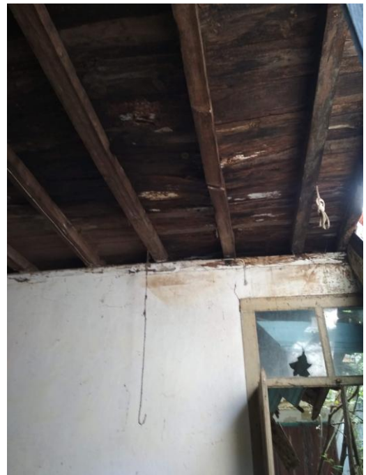
Foto n.º 4 – Vista do teto falso em madeira
