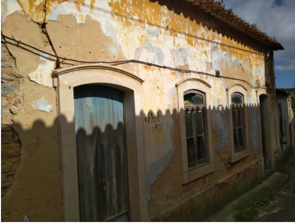
Foto n.º 5 – Vista da fachada principal
