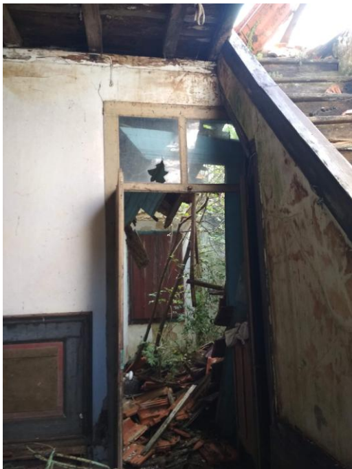
Foto n.º 3 – Vista interior da edificação
