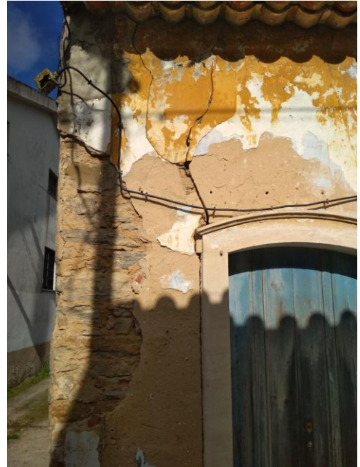
Foto n.º 2 – Vista exterior da edificação
