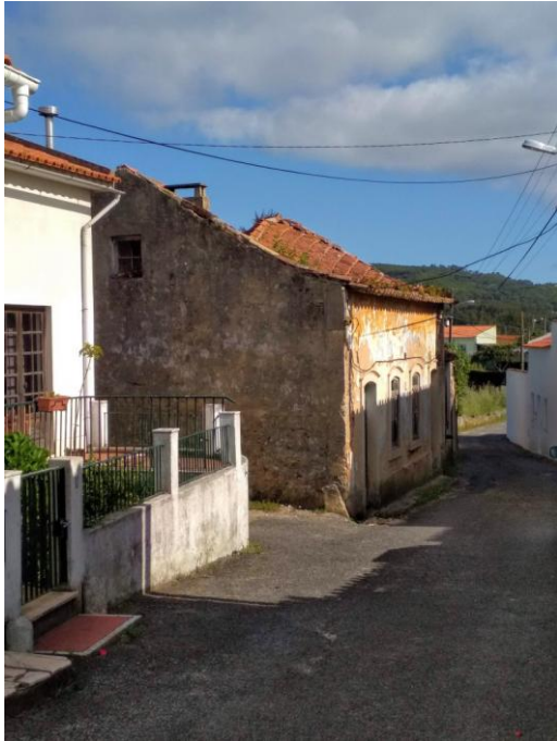
Foto n.º 1 – Vista exterior da edificação
