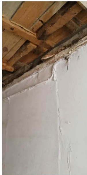
Fig 4 - Estrutura do teto
