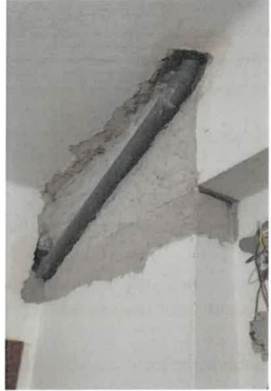
Foto n.º 2 – Vista do interior da Fração "O"
