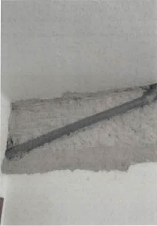
Foto n.º 1 – Vista do interior da Fração "O"
