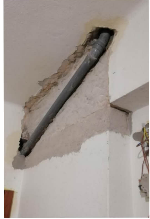
Foto n.º 2 – Vista do interior da Fração "O"
