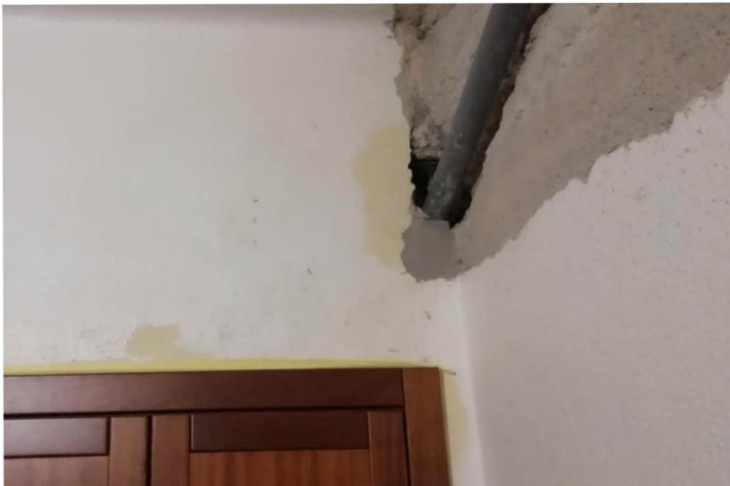
Foto n.º 3 – Vista do interior da Fração "O"
