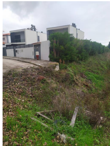
Foto n.º2 – Limite da pavimentação
