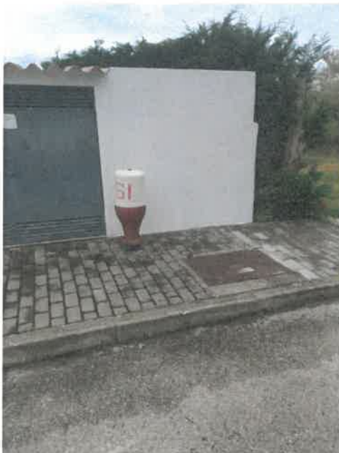
Foto n.º1 – Limite da pavimentação
