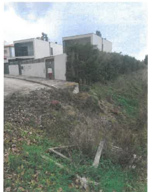
Foto n.º2 – Limite da pavimentação
