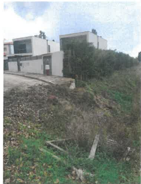
Foto n.º2 – Limite da pavimentação
