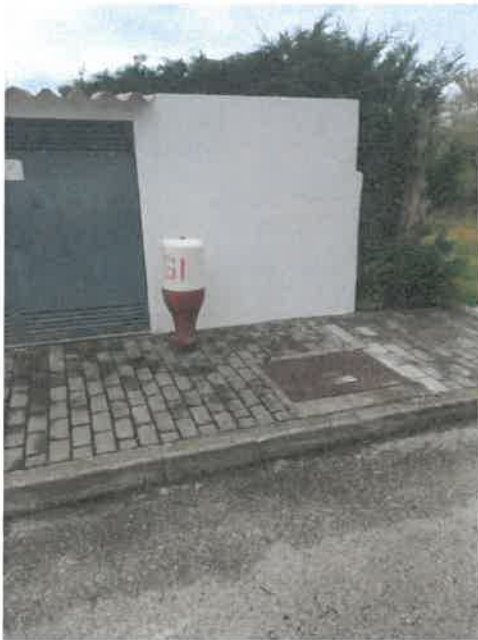
Foto n.º1 – Limite da pavimentação
