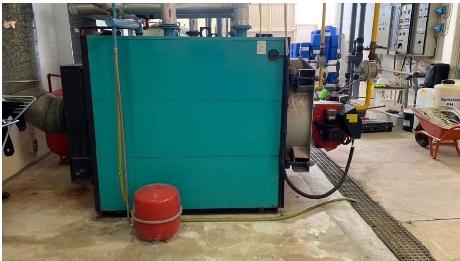
Lote 1 – Deposito AQS
