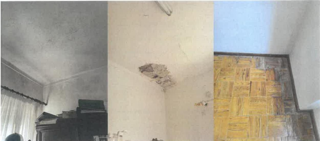
Foto 1 - tetos e paredes com bolor Foto 2 - Revestimento do teto da IS Foto 3 - pavimentos
